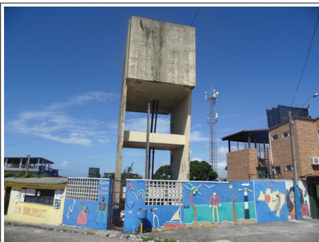
Fig.01- Vista de frente do imóvel
