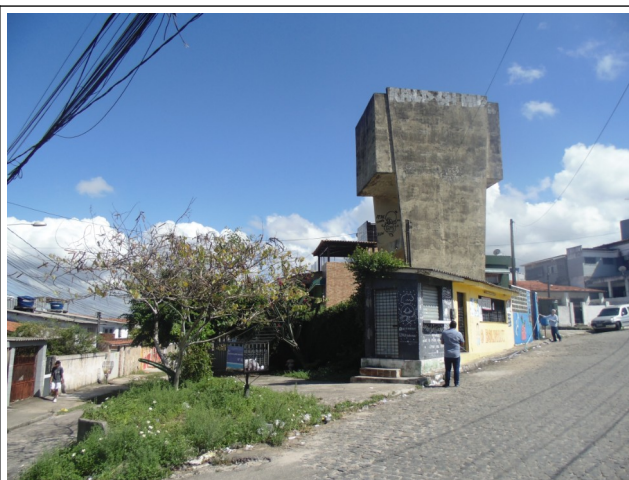
Fig.02- Vista do reservatório entre as Ruas Lucílio Varejão e Solidônio Leite Sobrinho
